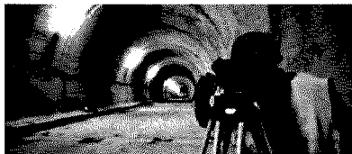
LAVORI Nel tunnel per Brignole [Maccarini]
